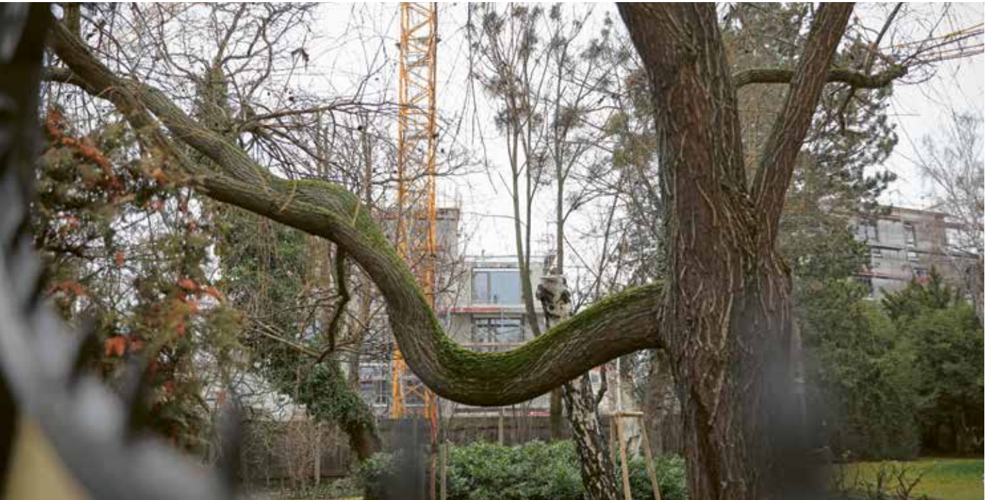
Von 2021 bis 2023 wird in der Lainzer Straße 127 eine große Wohnhausanlage samt Tiefgarage errichtet
